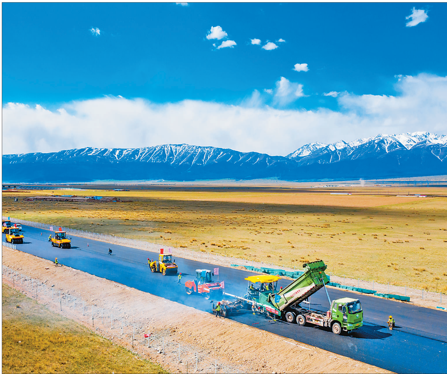
5月20日，京新高速公路与G575线新疆哈密至巴里坤段项目的交界处在铺设沥青。京新高速起于北京，终点至新疆乌鲁木齐，是“一带一路”通道的重要组成部分。 普拉提·尼亚孜摄(影像中国)
